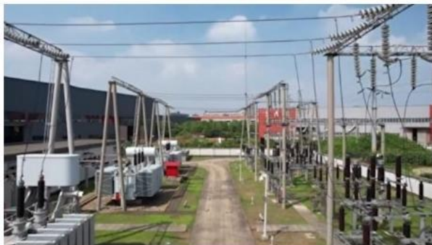
地空一体化巡检
