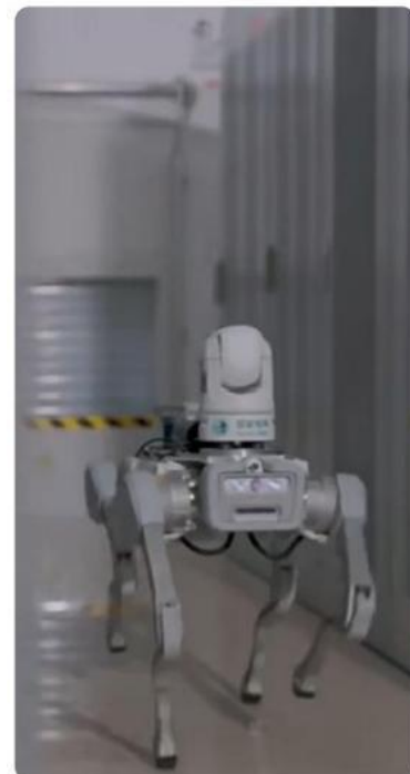
江苏某变电站巡检
